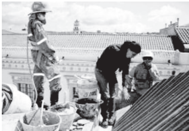
Control de calidad. Obra: Restauración Templo Nuestra Señora de la Merced
